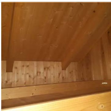
Hems og takkonstruksjon
