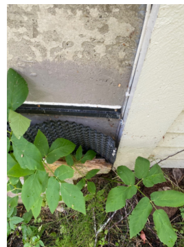
Avslutning av plast mot tiliggende bolig.
