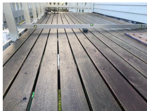
Høyde rekkverk ca. 94 cm.
