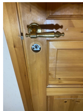
Manglende deksel for låsekasse.
