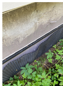
Avslutning av plast mot tiliggende bolig.
