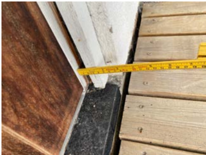
Glippe mellom dekkbord/ytterdør.
