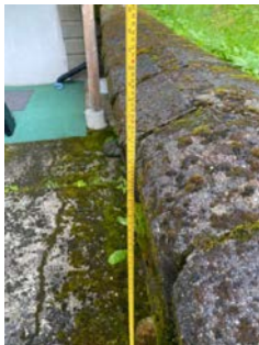
Det er påvist skjevheter i forstøtningsmurer.
