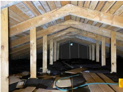
Takkonstruksjon med sperrer.
