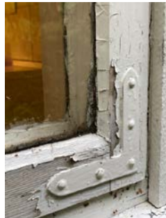
På grunn av vinduenes alder kan det på sikt påberegnes glasspunktering.
