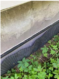
Avslutning av plast mot tiliggende bolig.
