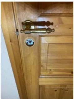
Manglende deksel for låsekasse.
