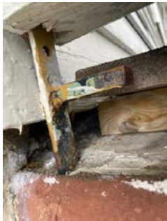
Rust i stolper, ingen synlig tekking av betongdekket.
