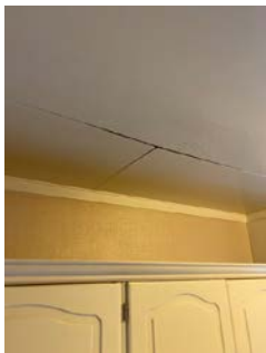
Det er påvist svellinger i takplater kjøkken og i trapperom.
