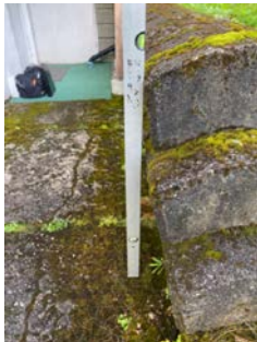
Det er påvist skjevheter i forstøtningsmurer.
