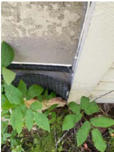
Avslutning av plast mot tiliggende bolig.
