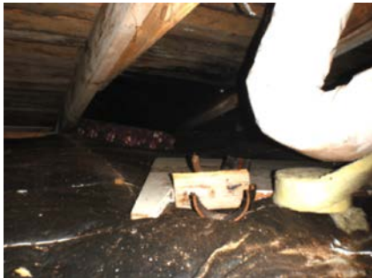
Råteskader/svertesopp.
