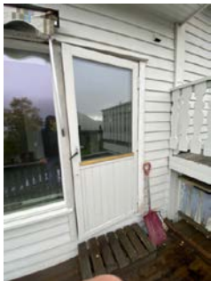
Glippe mellom dekkbord/ytterdør.
