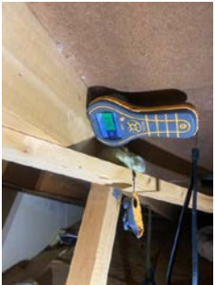
Det ble fuktmålt ved befaringen, ingen forhøyde verdier.
