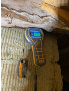
Det ble fuktmålt mot fuktskjolder mot pipen, ingen forhøyde fuktverdier.
