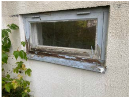
På grunn av vinduenes alder kan det på sikt påberegnes glasspunktering.
