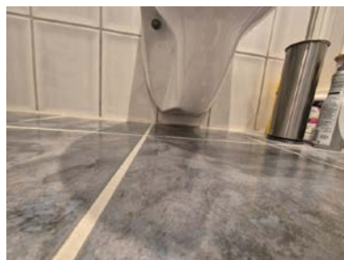
Ingen lekkasjehull under toalett.
