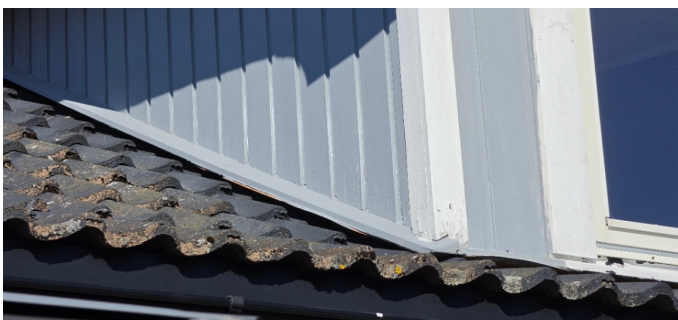
Kledning tak oppløft
