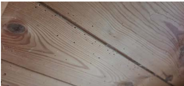
Spor etter bore biller i bjelker og stubbeloft
