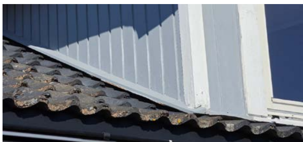
Kledning tak oppløft
