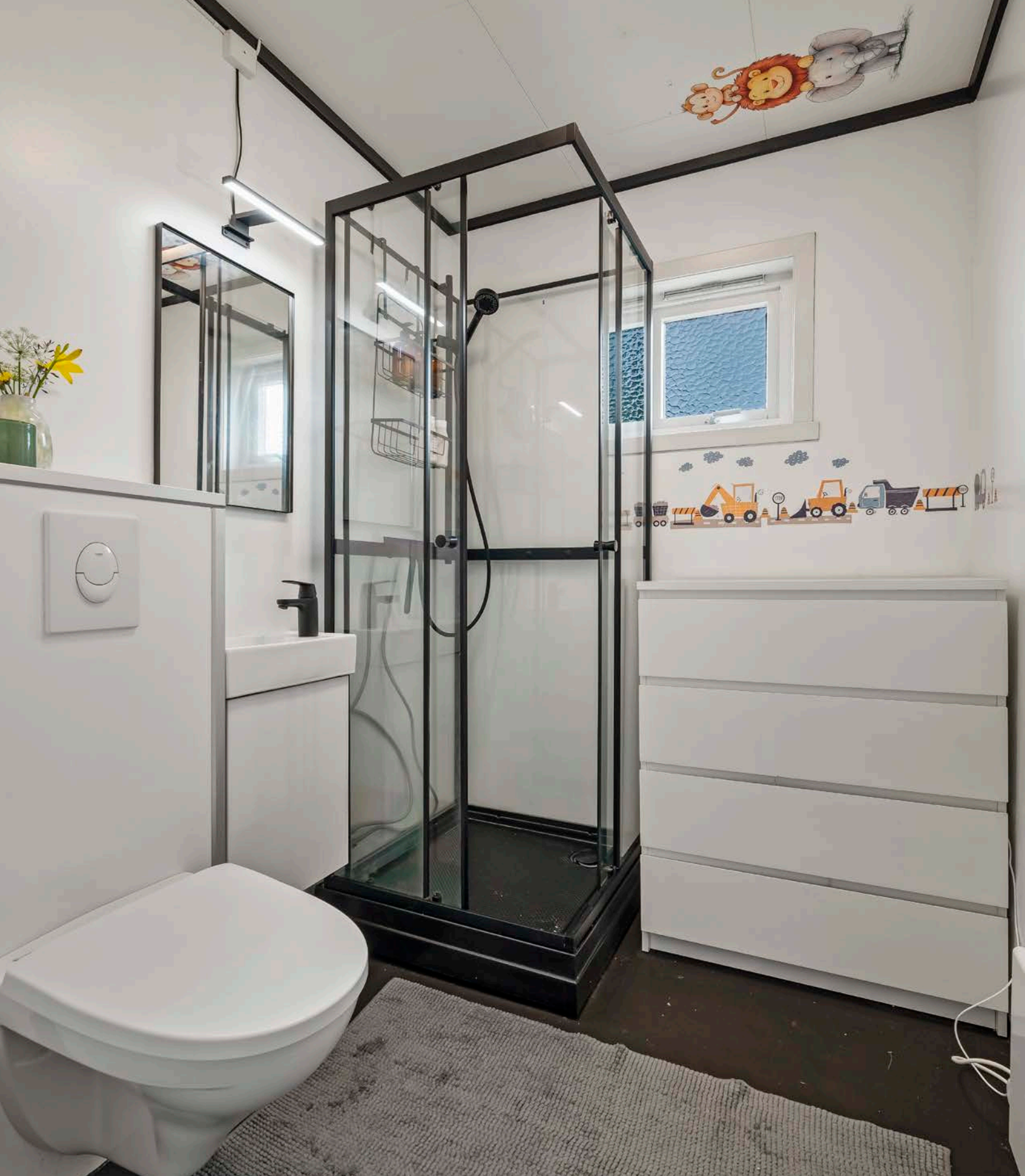
Eldre bad med malt belegg på gulv, og malte våtromsplater. Badet inneholder dusjkabinett og servant, samt veggheng wc. Det er opplegg for vaskemaskin på bad.
