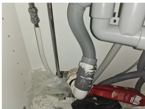
Avløpsrør av plast og støpejern i boligen.
