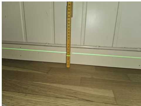
Etasjeskiller er kontrollert med nivelleringslaser.
