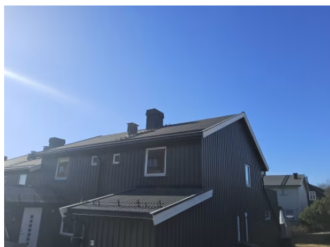
Taktekking av lakkerte metallplater.
