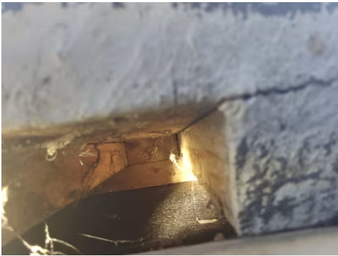
Det er benyttet treklosser som musetetting.
