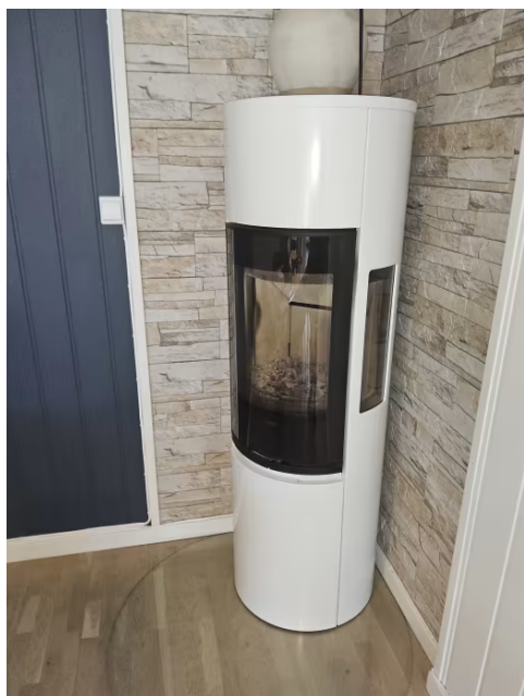
Vedovn med glassdør i stue.
