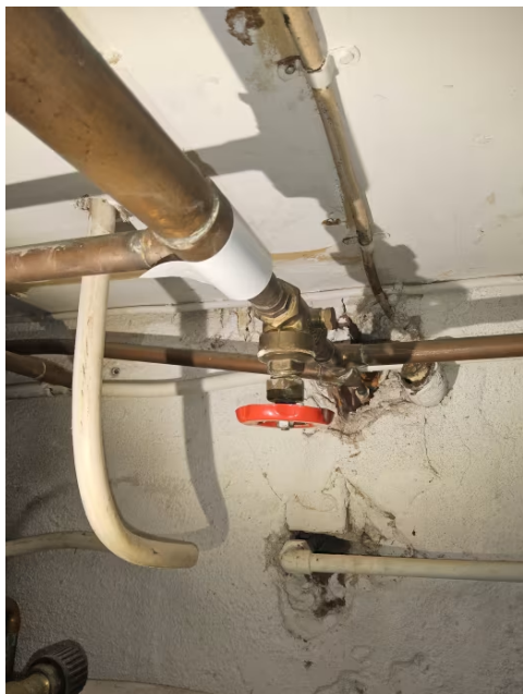
Hovedstoppekran av eldre type er plassert i naboenhet.
