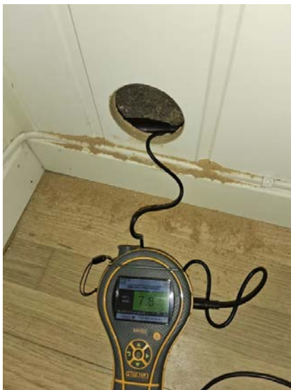
Bilde fra fuktmåling i utlektet kjellervegg.
