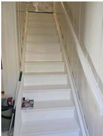
Trapp mellom første og andre etasje.
