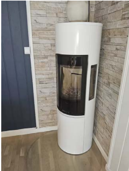
Vedovn med glassdør i stue.
