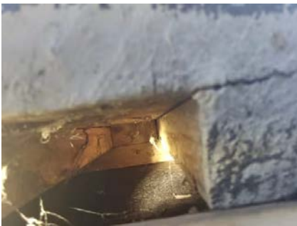
Det er benyttet treklosser som musetetting.
