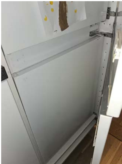
Fronter er ikke fastmontert til kjøleskap med fryser.
