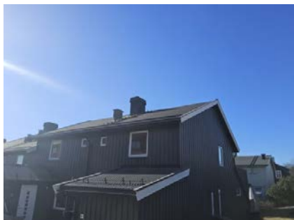
Taktekking av lakkerte metallplater.
