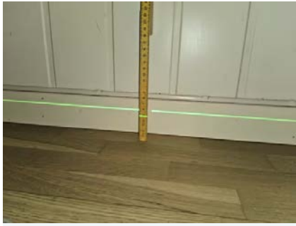
Etasjeskiller er kontrollert med nivelleringslaser.
