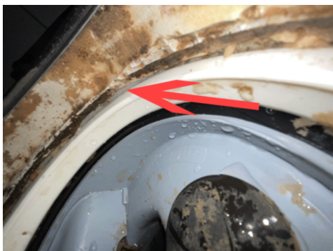
Glippe mellom membran og klemring.
