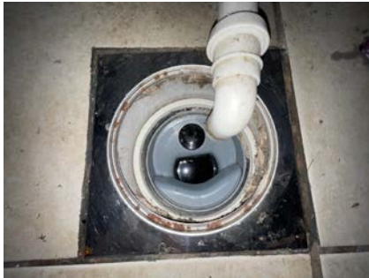
Plastsluk med synlig membran under klemring.
