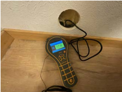
Fuktmåling i vegg.
