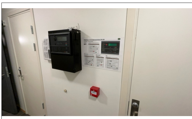
Felles brannvarslings anlegg.
