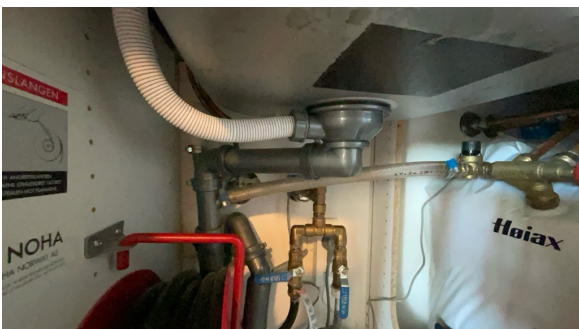
Del av rør til avløp.
