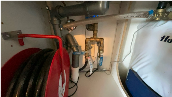
Del av rør til vann.
