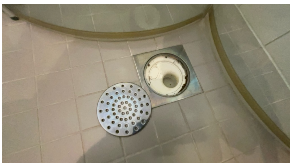
Sluk i gulv.
