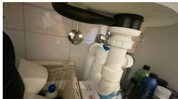
Del av rør til avløp.
