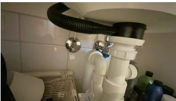
Del av rør til vann.
