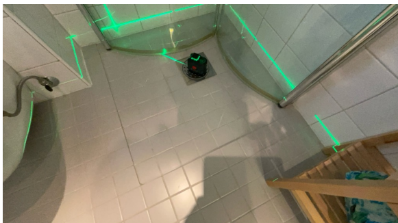
Målt fall på gulv. Del av gulv.
