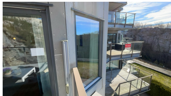
Eksempel på vindu i yttervegg.
