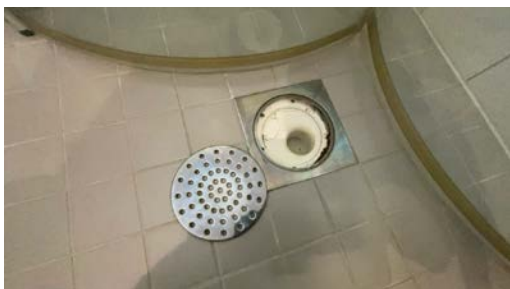
Sluk i gulv.
