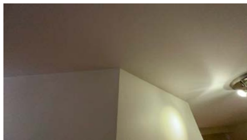
Del av vegg - tak.
