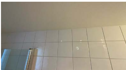
Del av vegg - tak.
