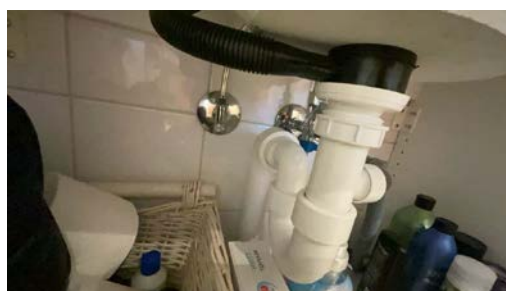
Del av rør til avløp.
