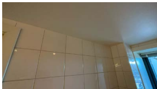
Del av vegg - tak.
