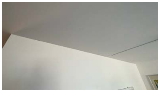
Del av vegg - tak.
