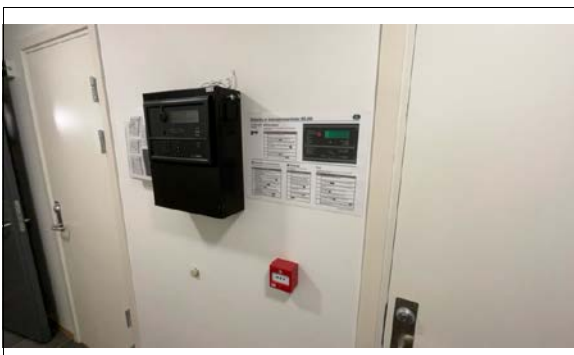
Felles brannvarslings anlegg.
