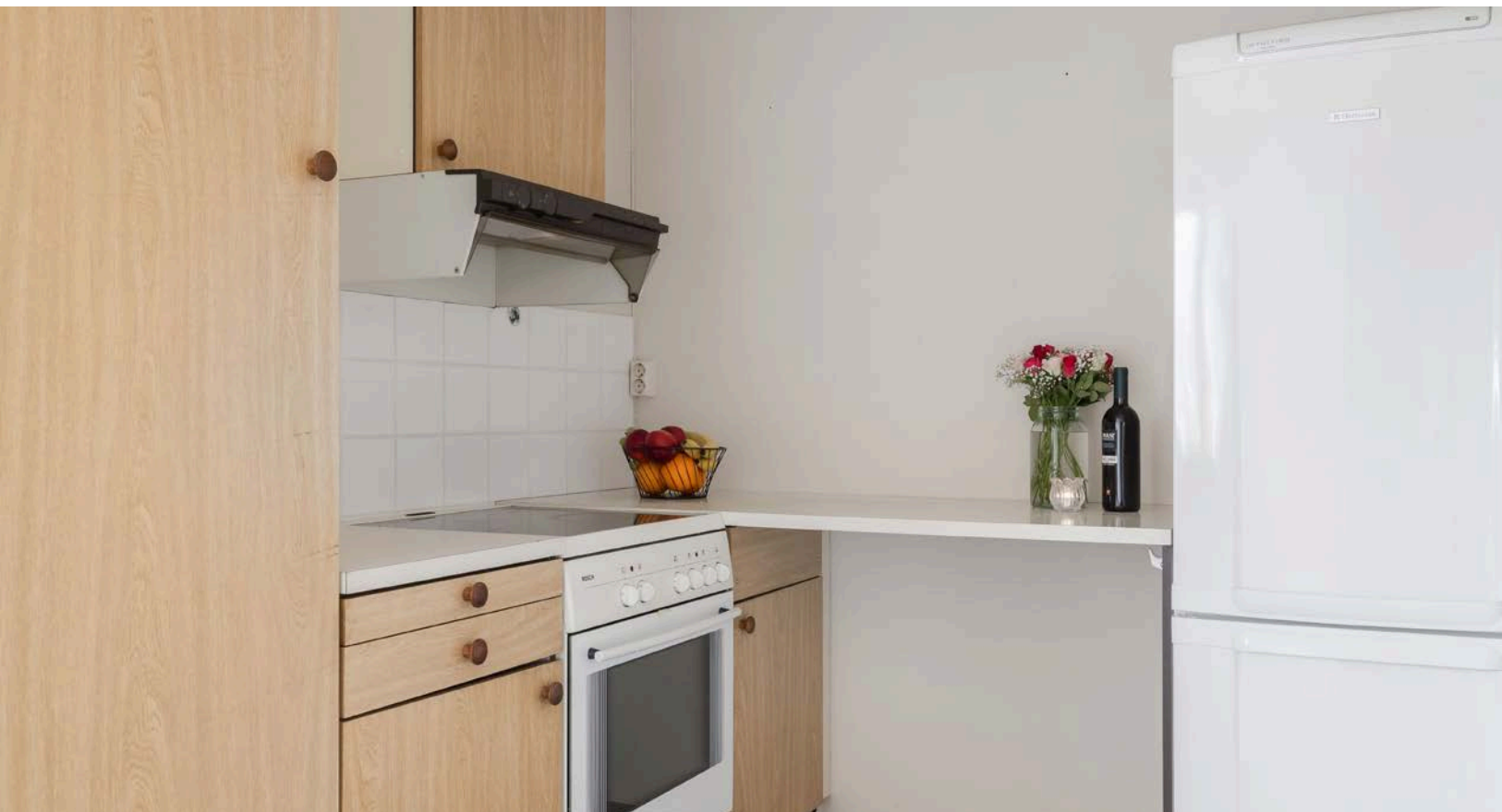
Kjøkkenet består av over- og underskap med glatte fronter. Laminerte benkeplater med fliser i benkeryggen flere steder.
