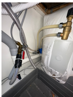
Røropplegg i kjøkkenbenk med Waterguard
