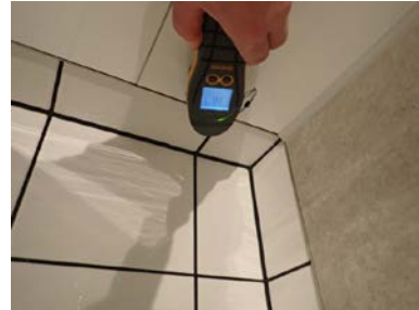
Ingen avvik ved overflatesøk i fuktutsatte områder.
