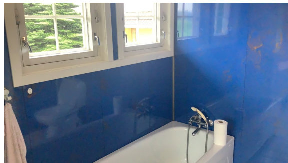
Vinduer er plassert i den definerte våtsonen over badekar.
