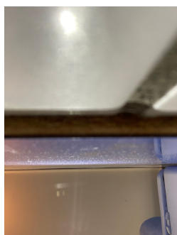
Bunnen av baderomsplater er ikke forseglet.
