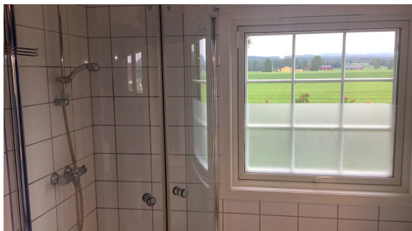
Vindu er plassert i den definerte våtsonen ved dusjhjørnet.
