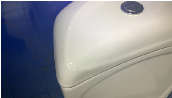
Riss i toalett.
