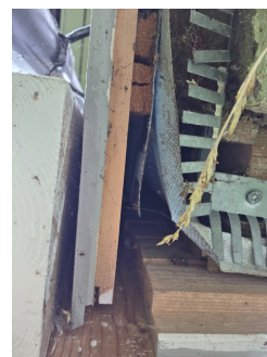
Mangler dekkbord over vindspærre på gavelvegg mot veranda.
