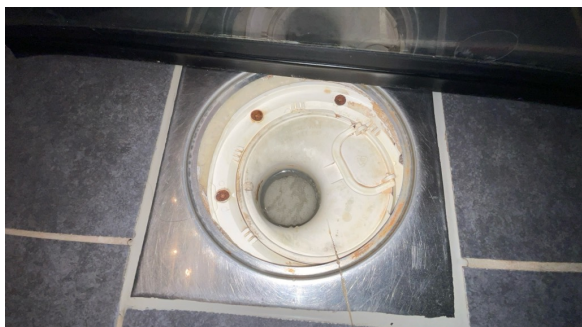
Vinylbelegg er ført ned under klemring i sluk i dusj
