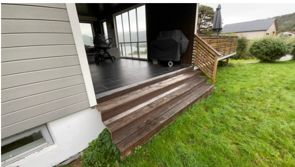
Plassbygd trapp med rekkverk på en side
