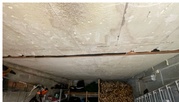
Synlig styropor i himling
