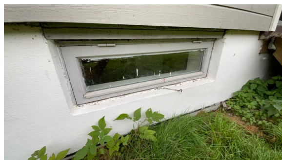
Vindu i kjeller
