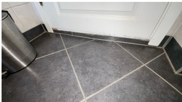
Det er målt høyde på gulv og på topp flis ved dør
