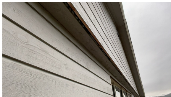
Mangler dekkbord over vindspærre på gavelvegg mot veranda.
