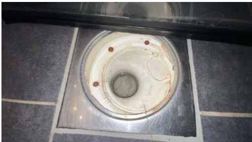
Vinylbelegg er ført ned under klemring i sluk i dusj
