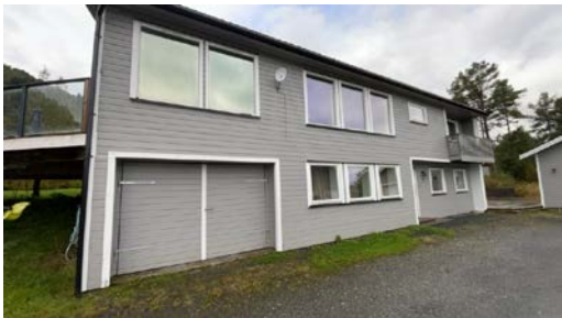
Oversikt. Bordkledning går stedvis nesten helt ned i terreng.
