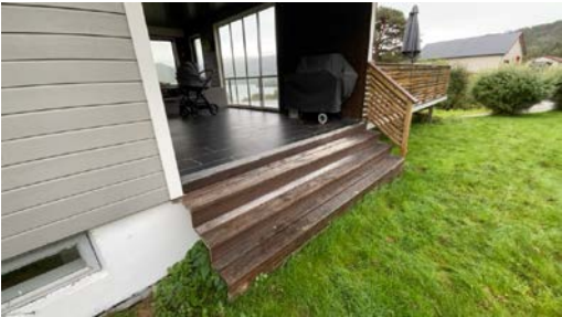
Plassbygd trapp med rekkverk på en side
