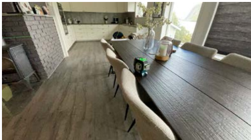
1. etasje Plassering av laser ved kontroll av stue/kjøkken. Det er målt 18 mm høydeforskjell gjennom rommet. TG 2.
