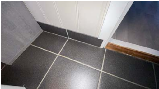
Veggflis er montert utenpå veggplater
