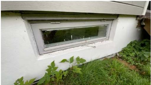
Vindu i kjeller
