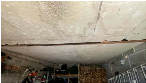
Synlig styropor i himling
