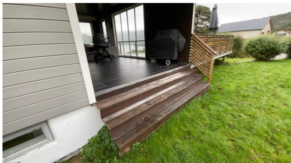
Plassbygd trapp med rekkverk på en side
