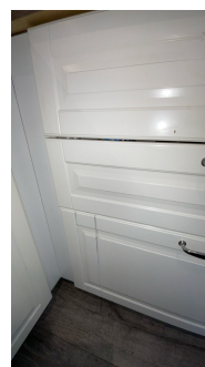
Overflateslitasje på fronter under vask
