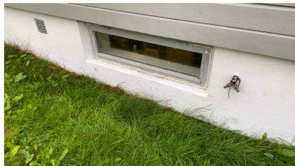
Vindu på vaskerom
