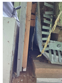
Mangler dekkbord over vindsperre på gavelvegg mot veranda.
