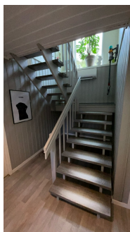
Trapp sett fra kjeller/underetasje
