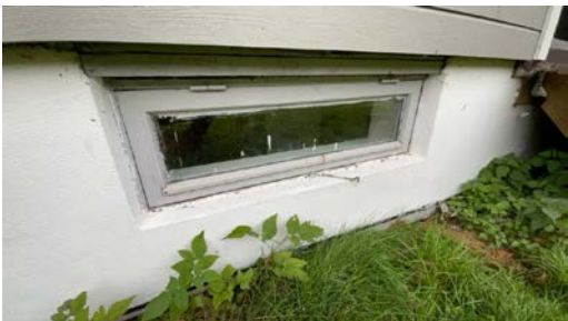
Vindu i kjeller
