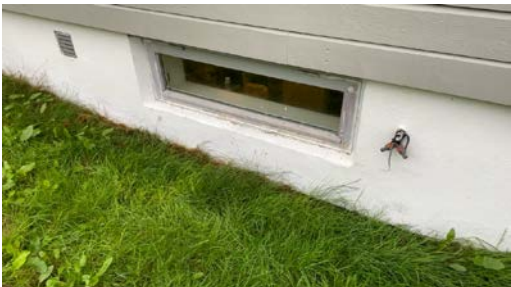
Vindu på vaskerom
