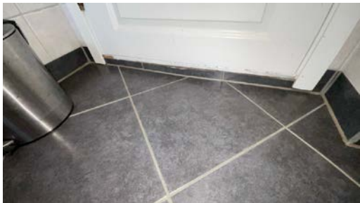
Det er målt høyde på gulv og på topp flis ved dør
