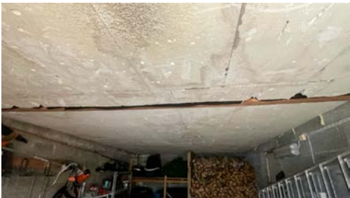
Synlig styropor i himling
