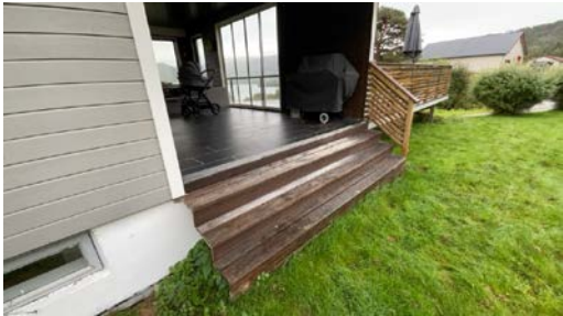
Plassbygd trapp med rekkverk på en side
