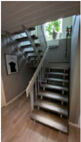
Trapp sett fra kjeller/underetasje
