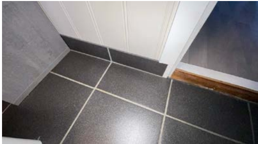
Veggflis er montert utenpå veggplater
