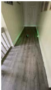
1. etasje Plassering av laser ved kontroll av gang. Det er målt 11 mm høydeforskjell gjennom rommet. TG 1. Over en avstand på 1,5 meter er det målt 11 mm fra døråpning mot stue langs skillevegg mot kjøkken. TG 2
