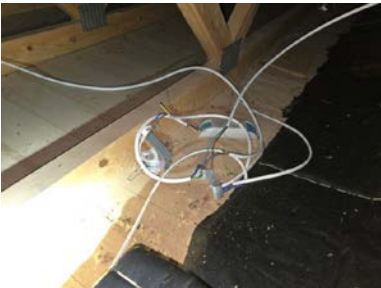
Åpne koblinger ved spotter over overbygd veranda og løse kabler mellom spotter
