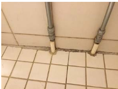
Rørføringer i dusjsone.
