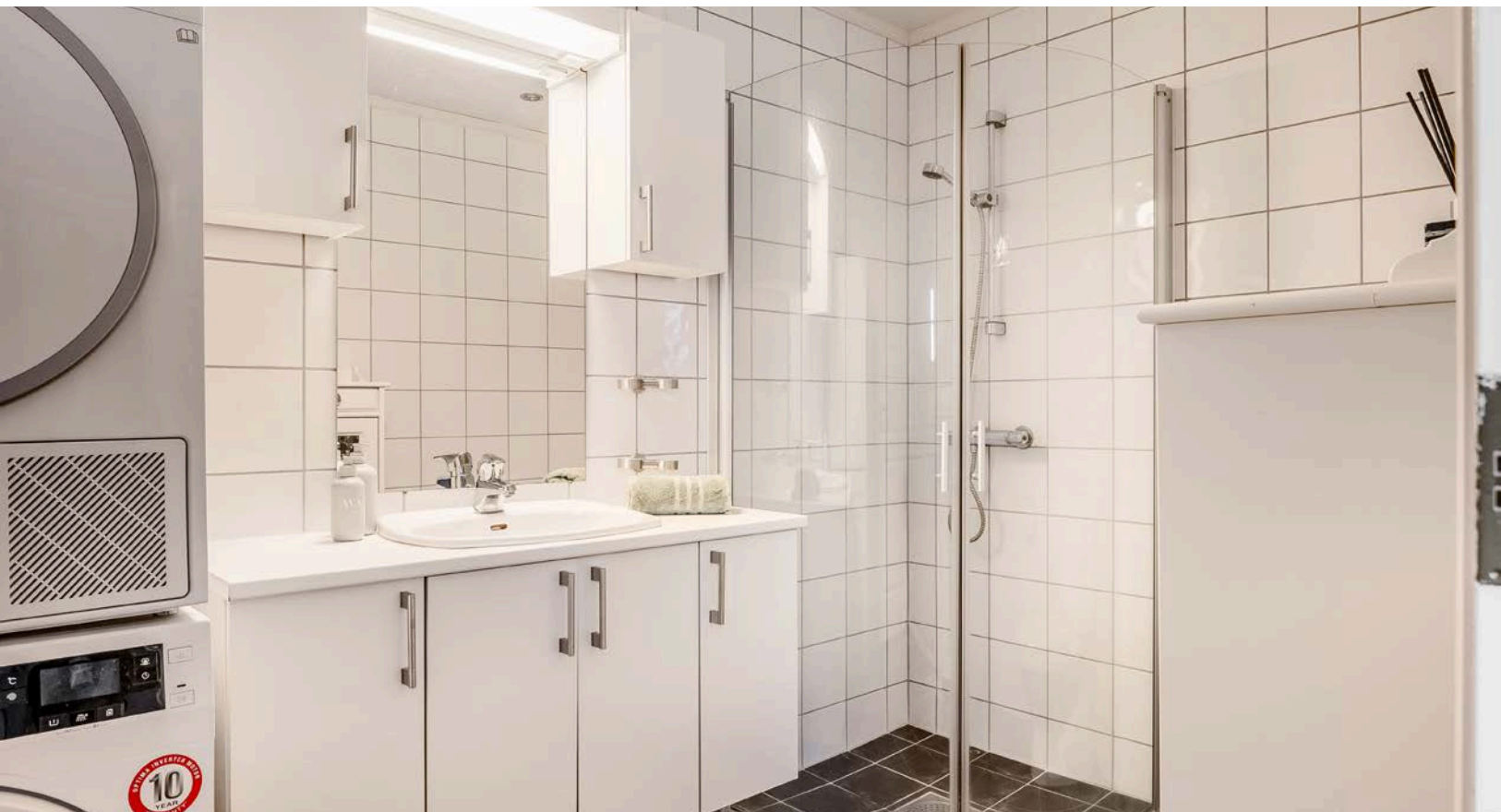
Lyst og moderne bad/vaskerom fra byggeåret 2004. Badet har mørke fliser på gulv med gulvvarme, hvite fliser på veggene, downlights i himlingen og mekanisk avtrekk.
