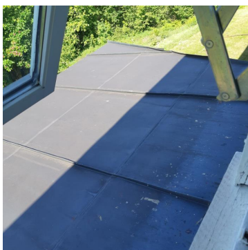
Tak med original båndtekkning
