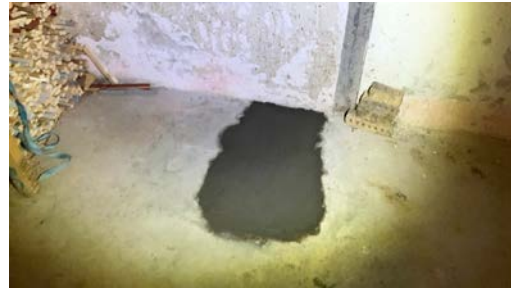
Lagt nytt avløpsrør rett inn forbi grunnmur.
