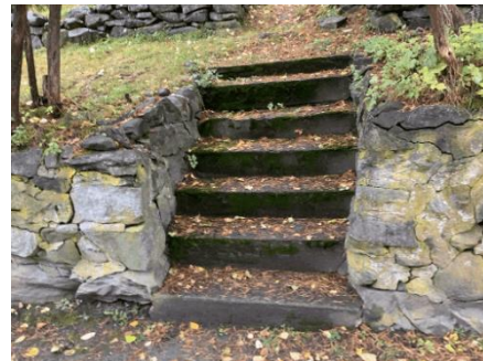
Trapp i terreng utvendig.
