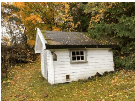
Bod i hagen. Bygget er ikke vurdert.
