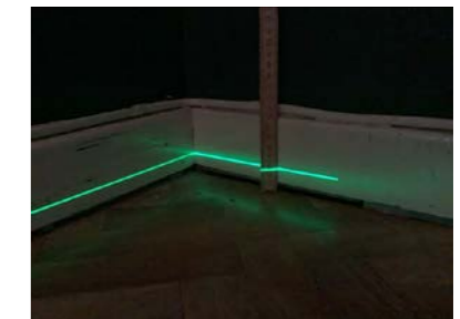
15 mm høydeforskjell i gulv soverom 2. etg.
