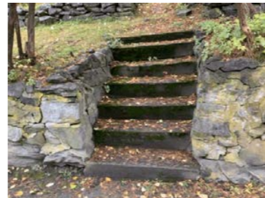
Trapp i terreng utvendig.
