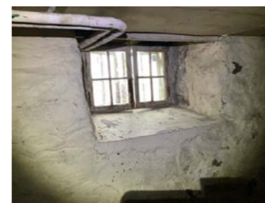
Tykkelsen på steinmuren gjør at det kan være usynlige råteskader i Treverk og organiske materiale anbefales fjernet, da det kan skape bunnsvill over mur.
