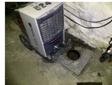
Avfukter er i bruk på befaringdagen.
