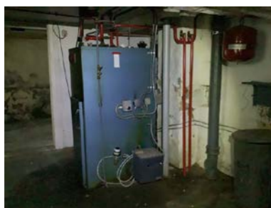
Sentralfyr på parafin/fyringsolje.
