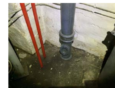
Soilrør i kjeller og nedstøpt i betonggulv.
