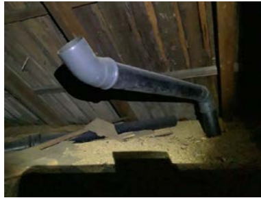
Lufterør, eller rør fra ventilasjon bad, er ikke ført gjennom taktekkning.
