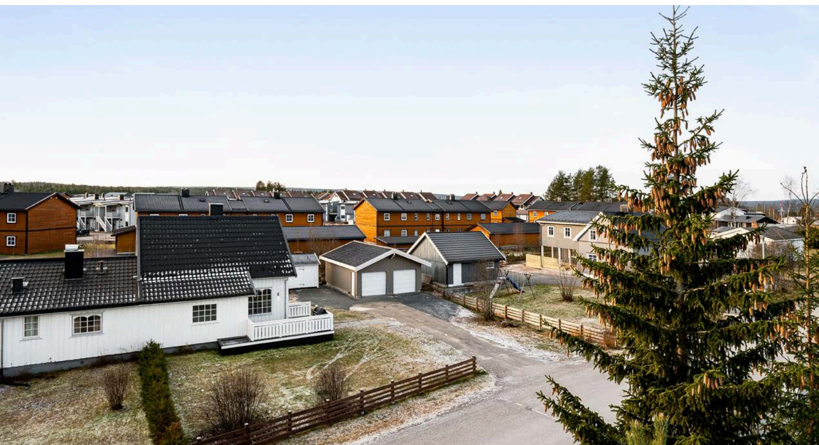
Garasje fra 2024 (noe gjenstående arbeider).
