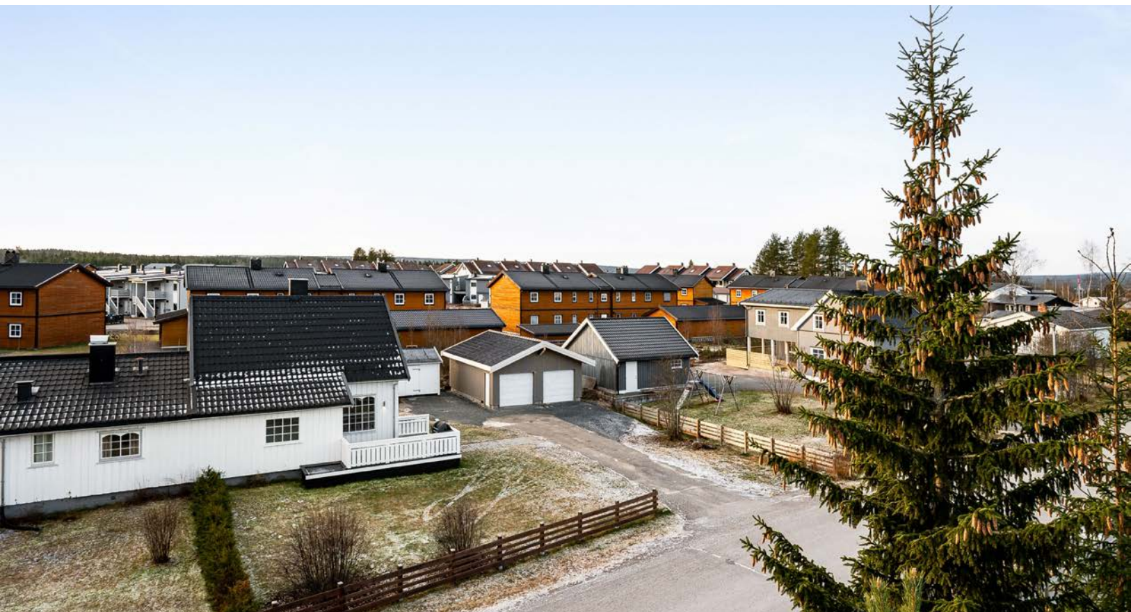
Garasje fra 2024 (noe gjenstående arbeider).
