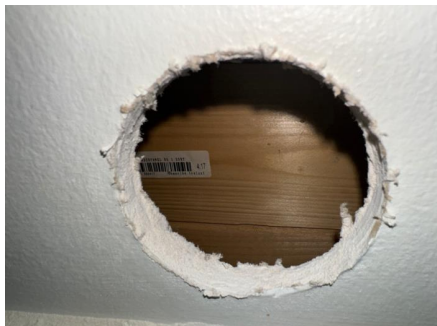
Hulltaking i tilstøtende kjøkken (bak dusjsone)
