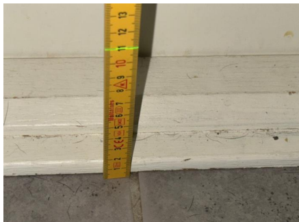
Fallforhold ca. 109 mm overkant gulv ved terskel
