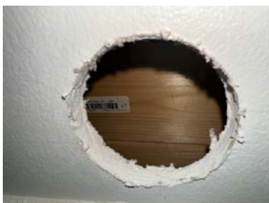
Hulltaking i tilstøtende kjøkken (bak dusjsone)
