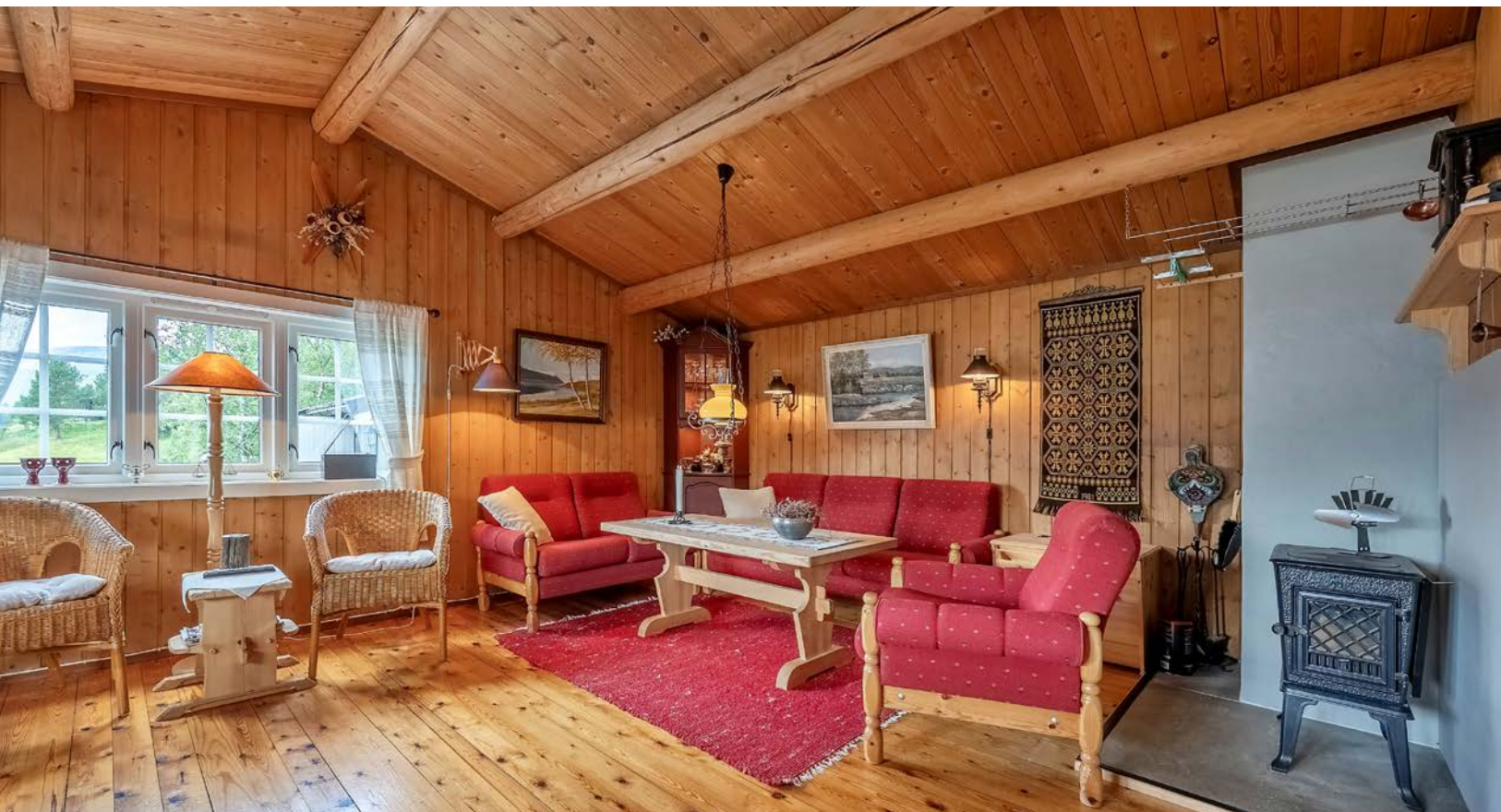
Det er innsatt peisovn og nytt innerrør i pipa ca. 2017
