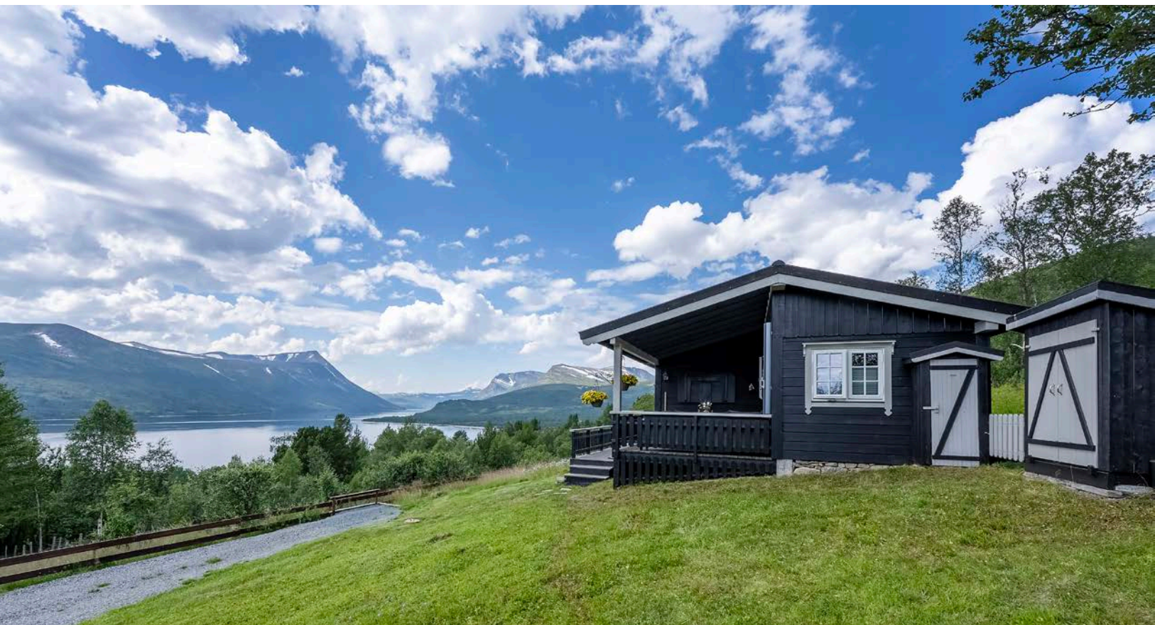
Fasade mot sørøst med vedskjul og en liten redskapsbod på veggen
