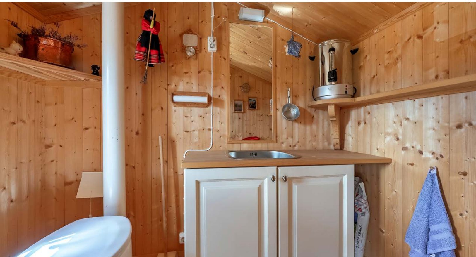
Toalettrommet har innredning med servant og elektrisk vannvarmer samt mulddo
