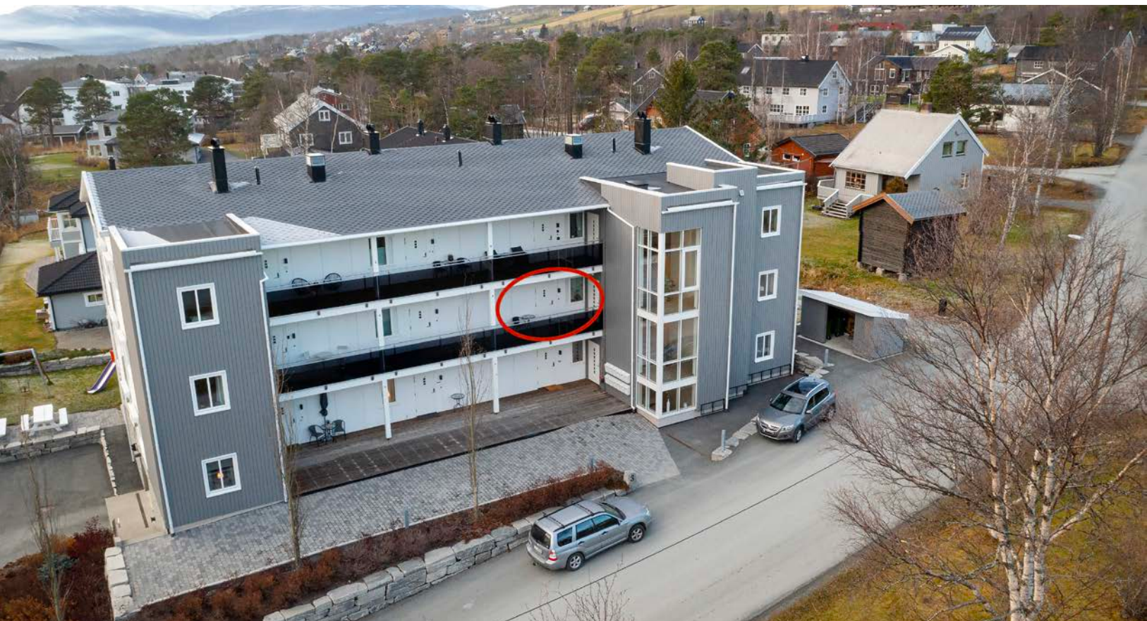
Fasade med markering
