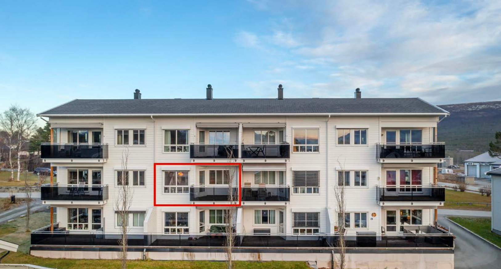
Fasade med markering
