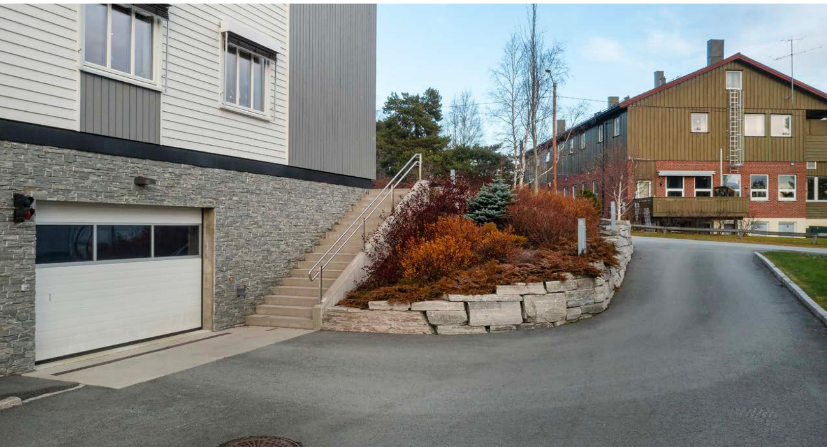
Innkjøring til parkeringskjeller
