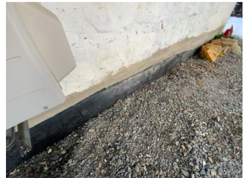
Kontroll av drenering/fuktsikring.
