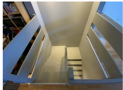
Besiktigelse av trapp.
