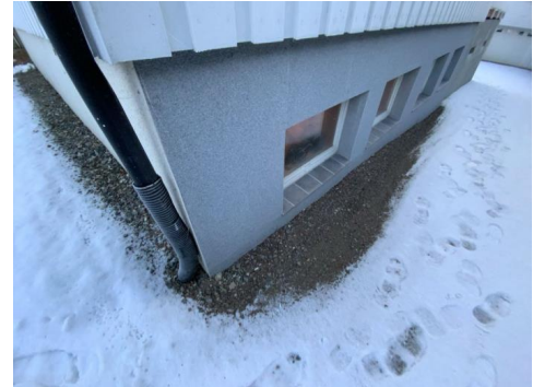
Kontroll av drenering/fuktsikring.
