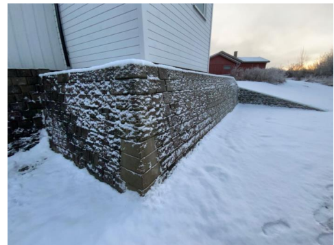
Besiktigelse av støttemur.
