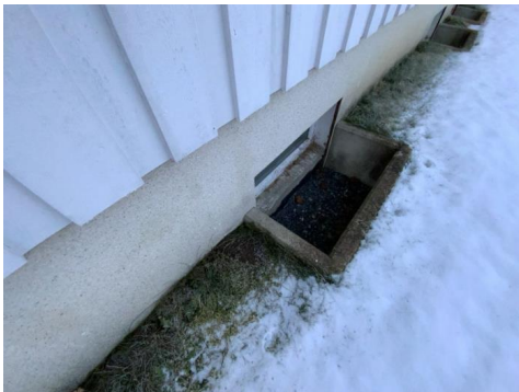
Kontroll av drenering/fuktsikring.
