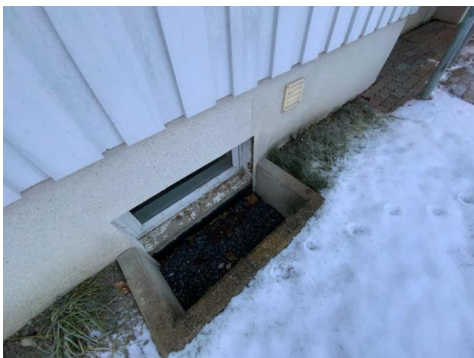
Kontroll av drenering/fuktsikring.
