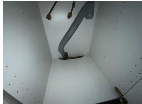
Besiktigelse av rørproplegg.
