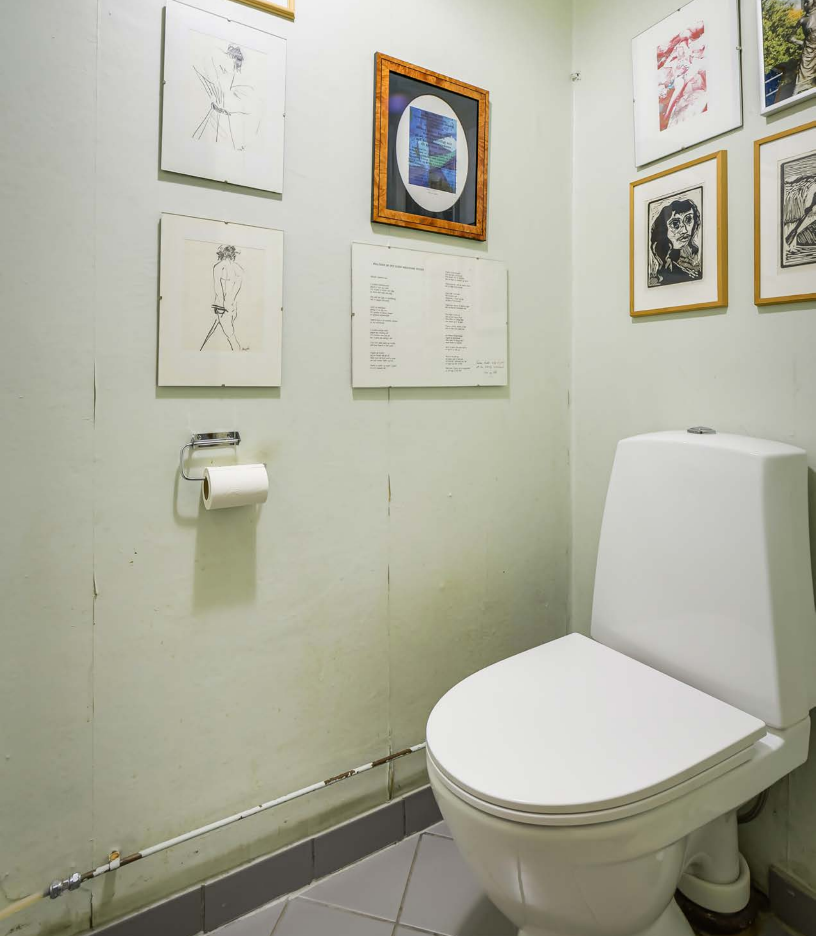
Separat toalettrom med flislagt gulv og malte vegg- og takflater. Rommet er utstyrt med et gulvmontert toalett.
