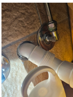
Rørgjennomføring under servant
