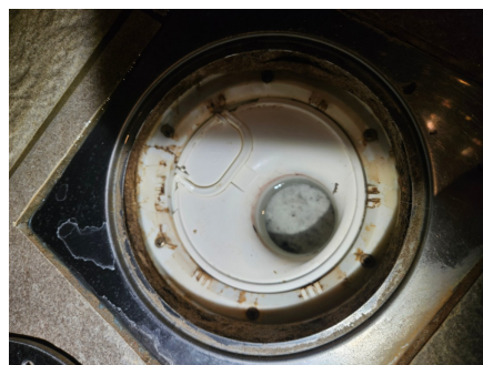
Kontroll av sluk i dusjsjonen.
