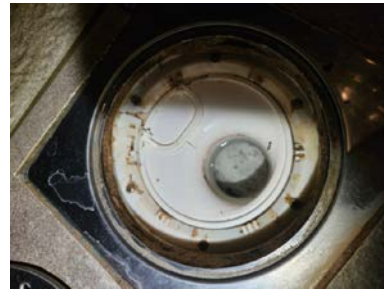
Kontroll av sluk i dusjsonen.
