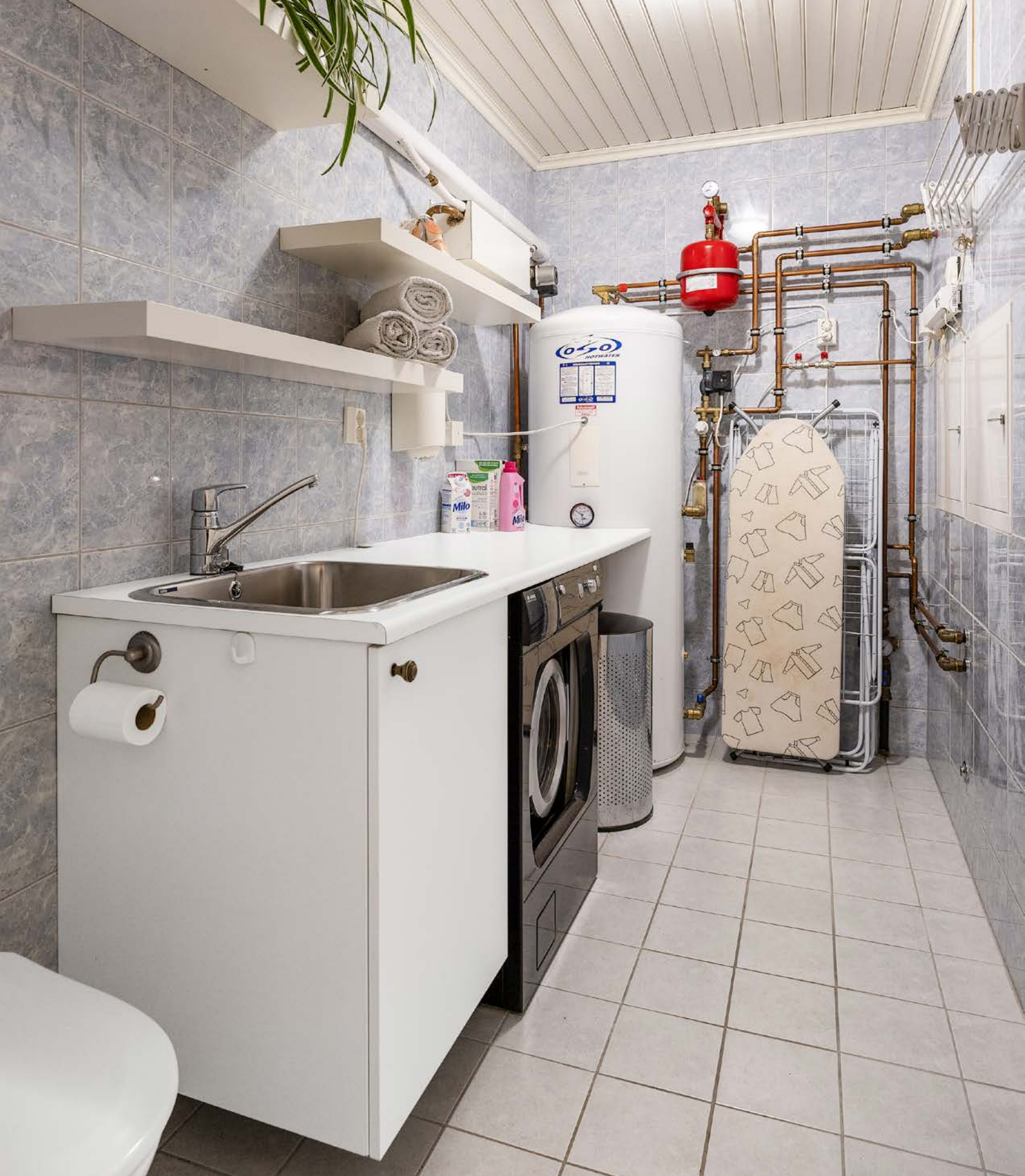
Vaskerommet har flislagt gulv, åpne hyller, toalett og arbeidsbenk med nedfelt utslagsvask. Det er opplegg for vaskemaskin og plass til tørketrommel.
