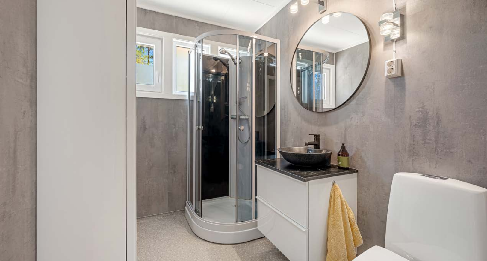
Badet ble renovert i 2023 og har belegg på gulv og våtromsplater på vegg
