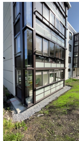
Eksempel på ferdig balkong på nabo bygg.
