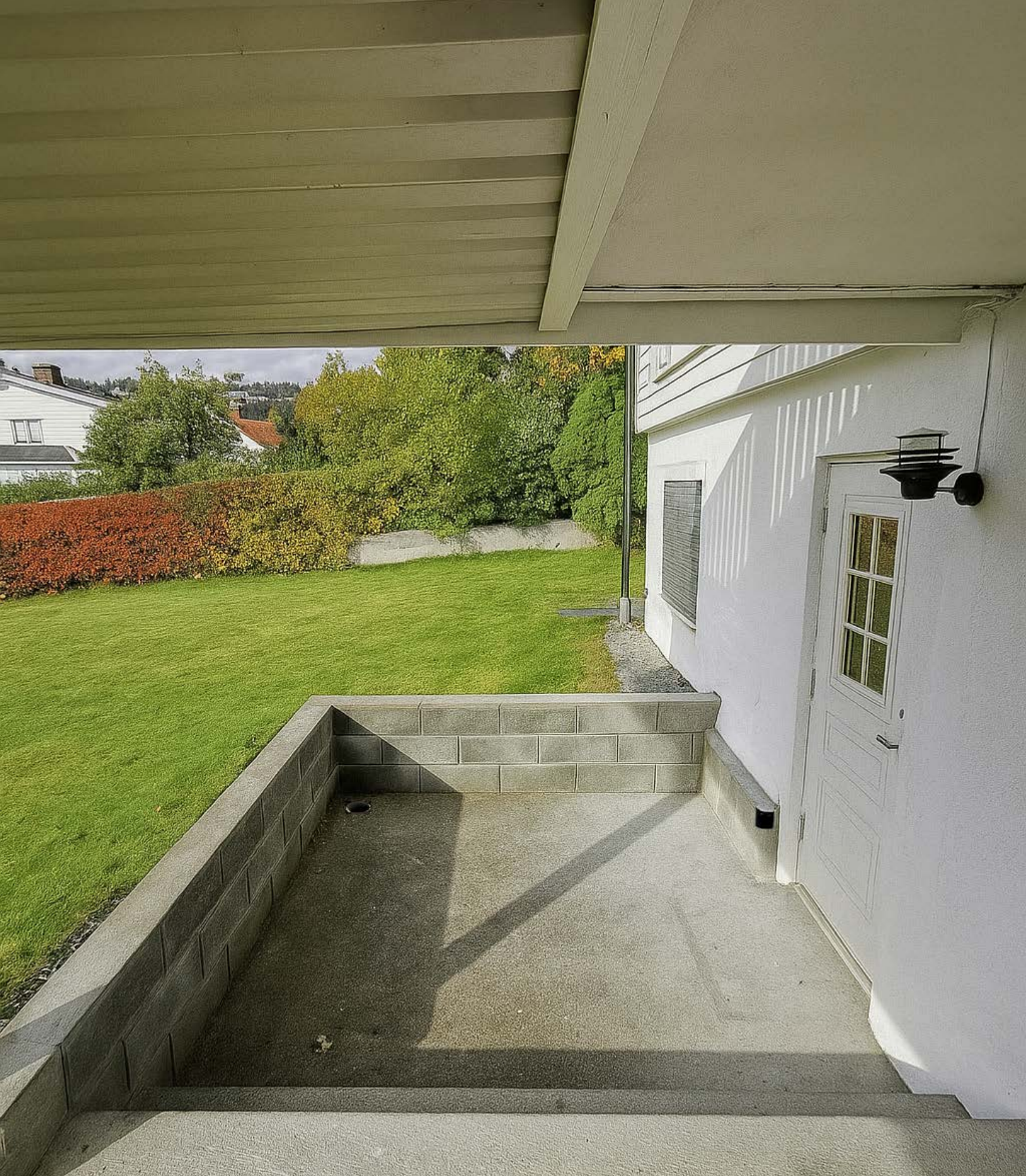
Inngang til underetasjen.
