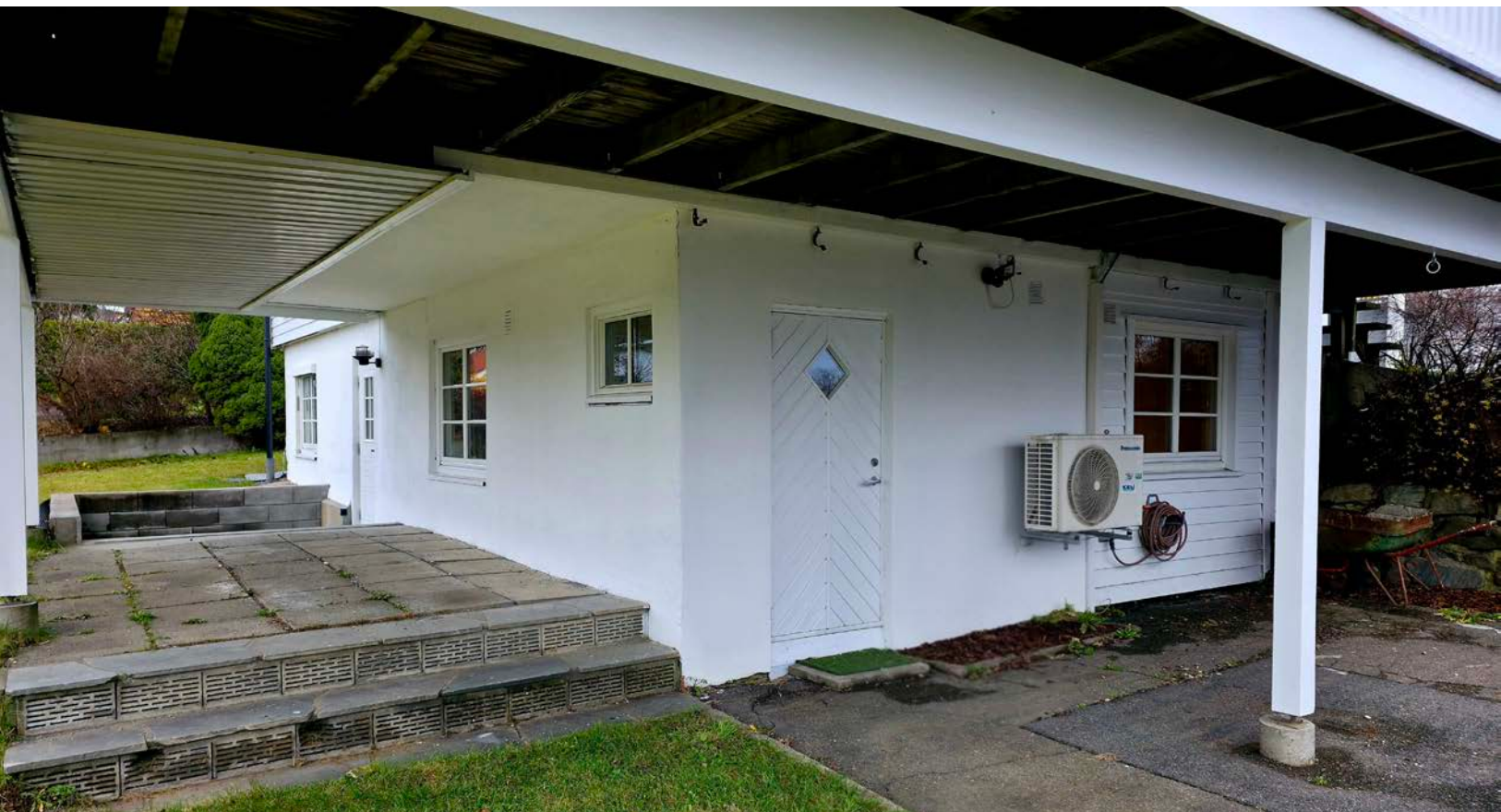
Overbygget uteplass ved underetasjen.
