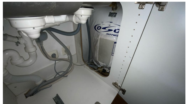
Besiktigelse av bereder.
