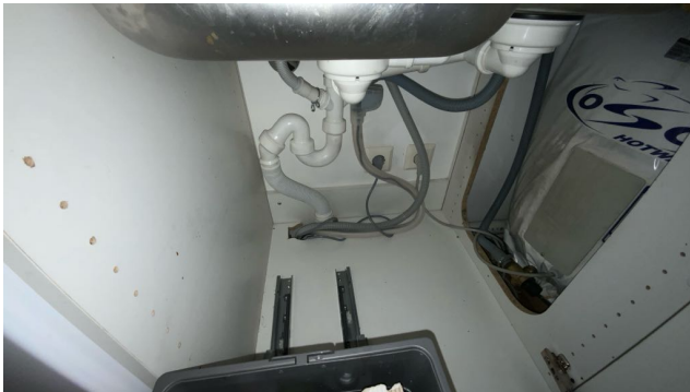
Besiktigelse av røropplegg.
