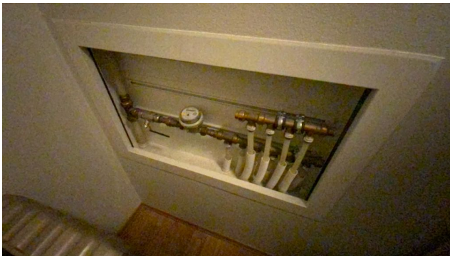
Besiktigelse av røropplegg.
