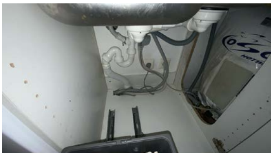
Besiktigelse av røropplegg.
