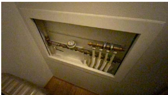
Besiktigelse av røropplegg.
