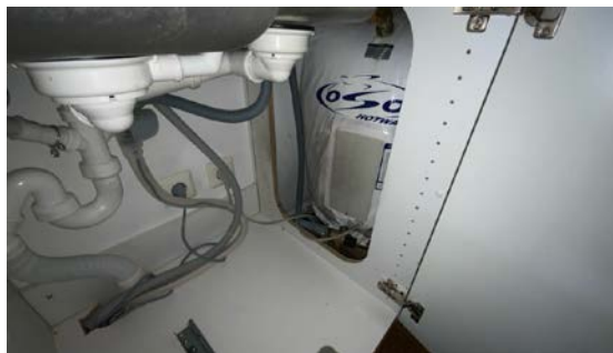
Besiktigelse av bereder.
