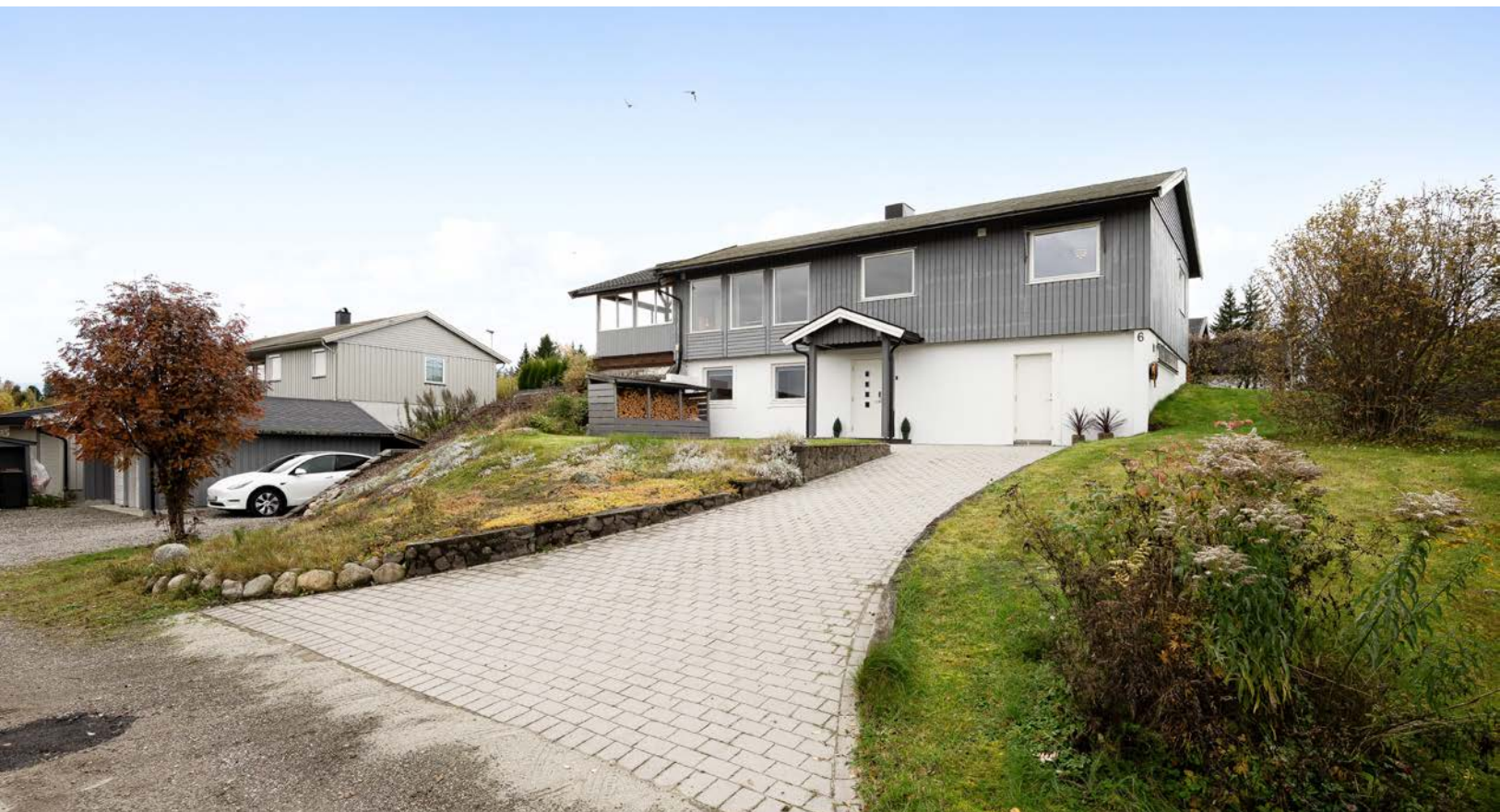
Tomten er meget pent opparbeidet. Oppkjørselen er belagt med belegningsstein og det er etablert en gangsti med heller fra garasjen og opp til boligen.
