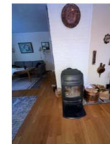
- Sprekk i glass på vedovn stue
