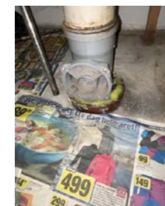
Det er synlig tett rundt avløpsrør på bod. Ingen lekkasjer på Plast avløpsrør er ført ned til betongrør i gulv på bod 2 befaringsdagen.
