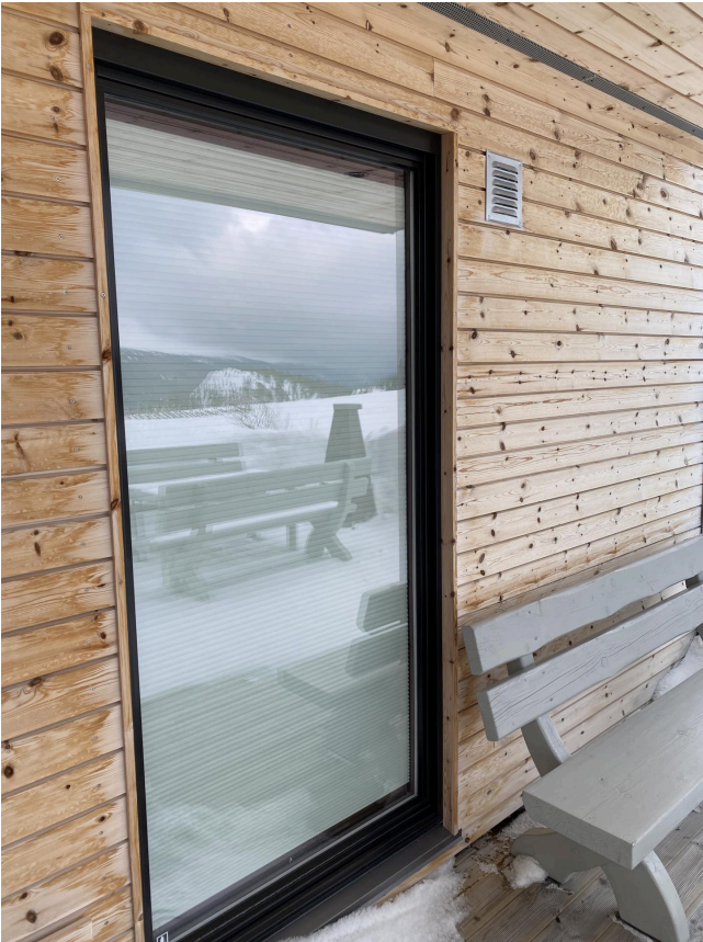
Utførelse av vindu.
