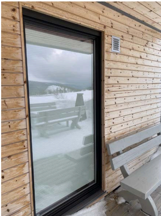
Utførelse av vindu.
