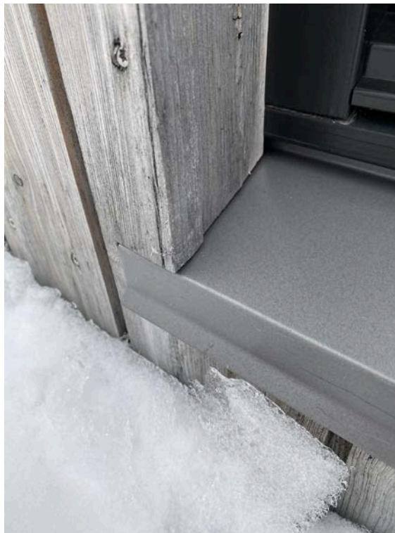
Utførelse av beslag på vannbrett. Det er ukjent om beslaget har oppbrett på kortsiden. Oppbrett vil være en fordel for å hindre vanninntrengning på vindspærre.
