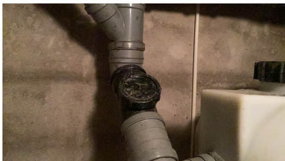
Stakepunkt i kjeller.
