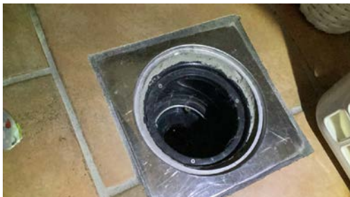
Det er ikke tegn til membran i sluk.
