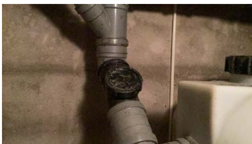
Stakepunkt i kjeller.
