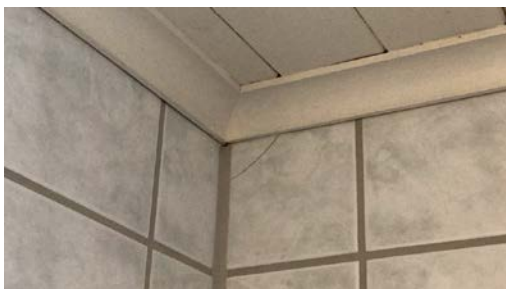
Eksempel på sprekk i flis.
